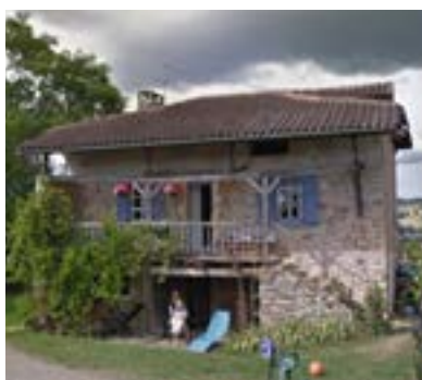
Transformation d'une construction ségalienne en habitation
