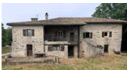
Maison-bloc à Latronquière © Label Pierres
