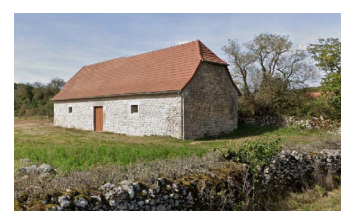
Bâti agricole récemment restauré à Quissac
