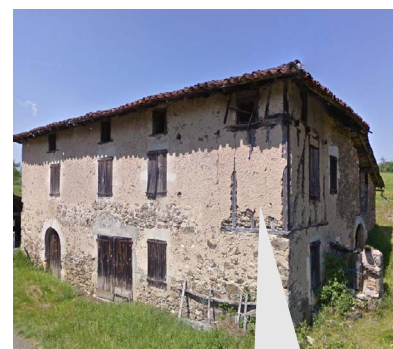
Bolet ayant été comblé à l'enduit (lieu-dit Guirande)
