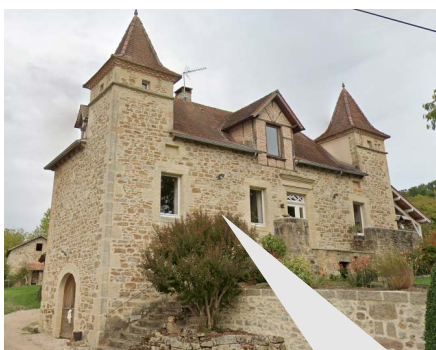
Ancienne maison-bloc réhabilitée à Four (Mas des Cazes)
