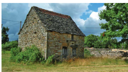
Toiture en lauzes de calcaire © CAUE du Lot
