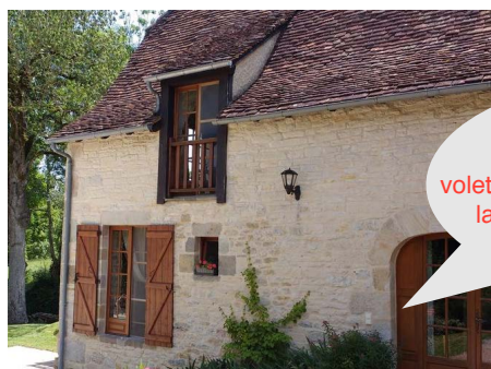
Grange réhabilitée en gîte © La grange quercynoise
