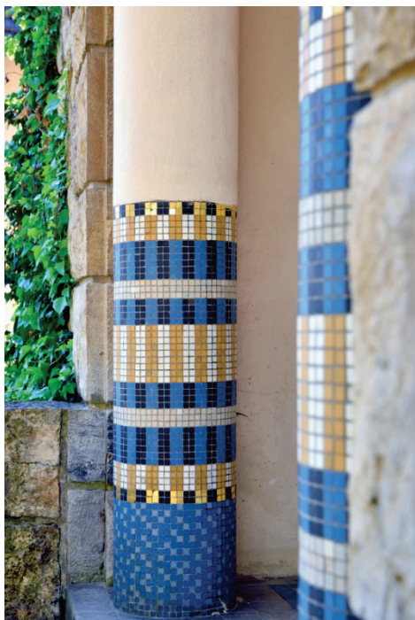
Détail, bain-douche de Capdenac-Gare – ©Jérôme Morel
