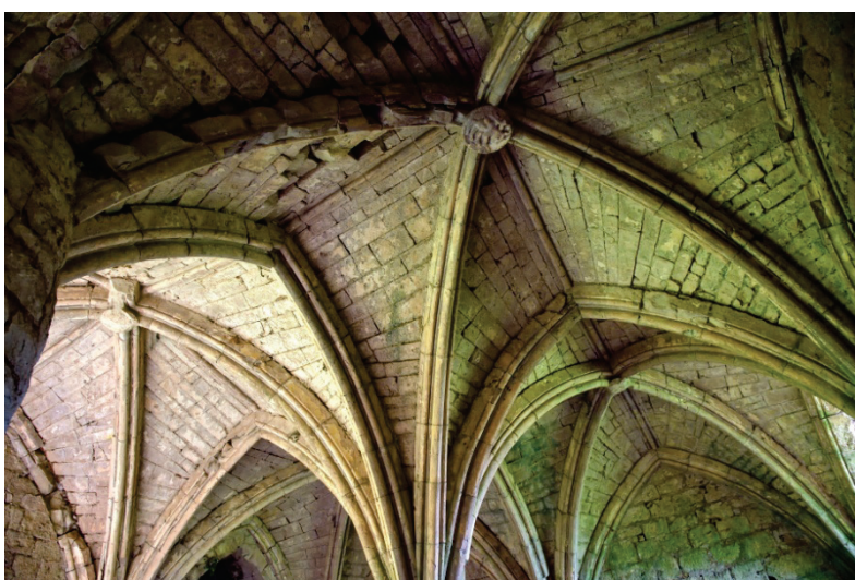
Voûte de la salle capitulaire de l'Hôpital-Beaulieu, Issendolus – ©Jérôme Morel
