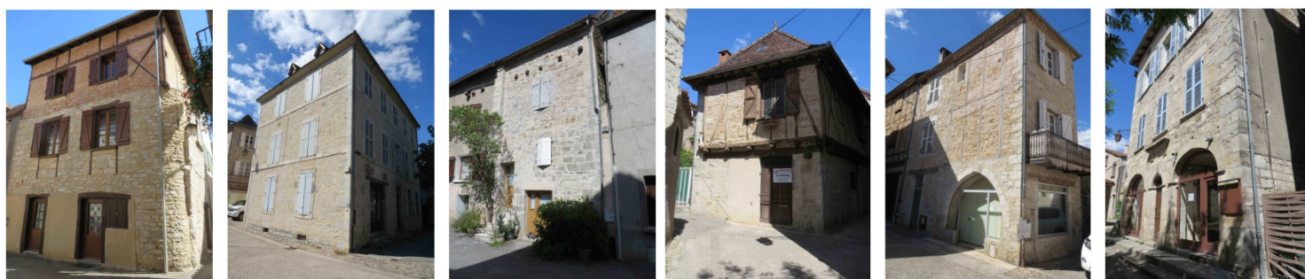
40. Extrait du recueil photographique des édifices remarquables et de caractère présent dans le diagnostic.
