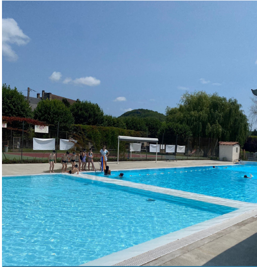
Piscine intercommunale de Cajarc
