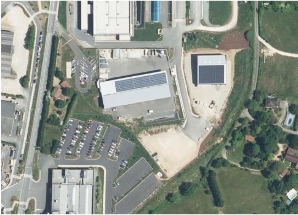
Figure 2 : Photo aérienne du site
