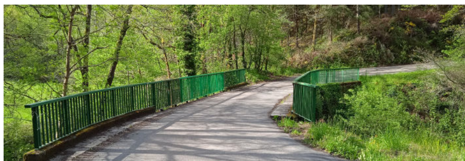
Pont avant travaux
