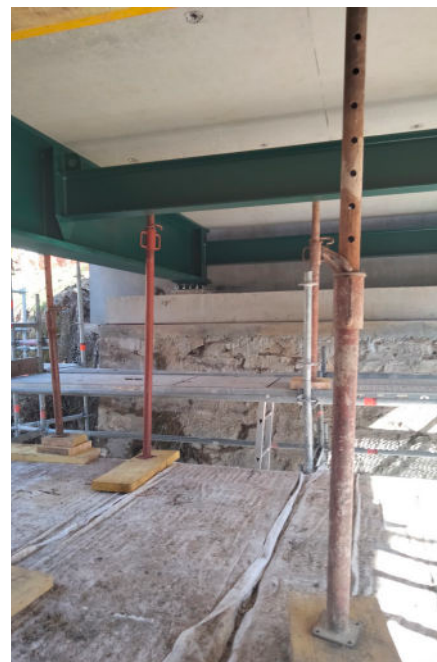
Vue de la charpente métallique
