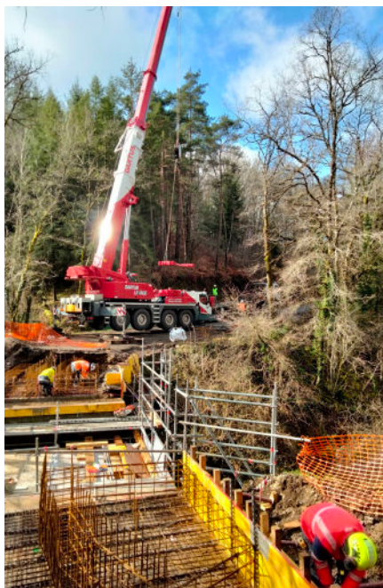
Grutage des sommiers
