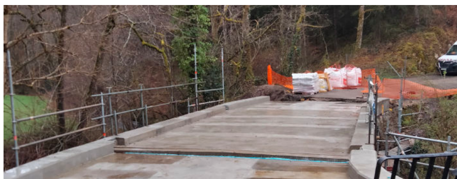
Pont avant réfection de la chaussée
