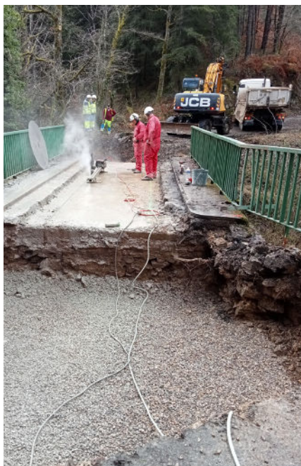
Découpage du tablier existant
