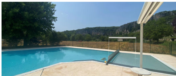
Piscine intercommunale de Saint-Sulpice
