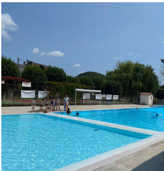
Piscine intercommunale de Cajarc
